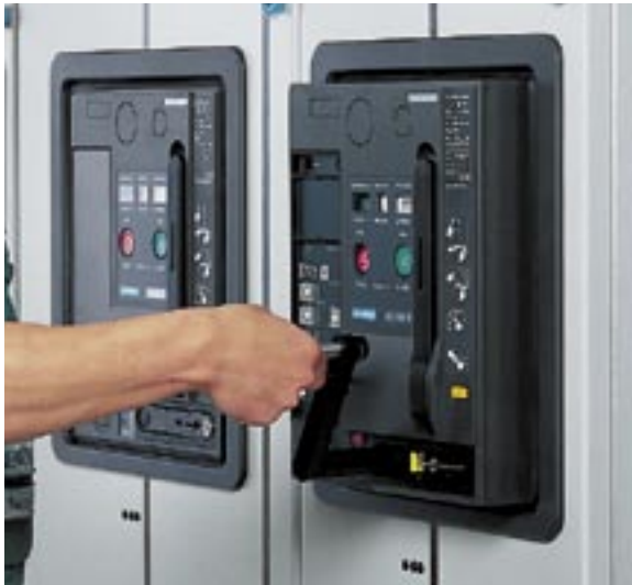
当门关闭时，断路器可可靠的移动。
